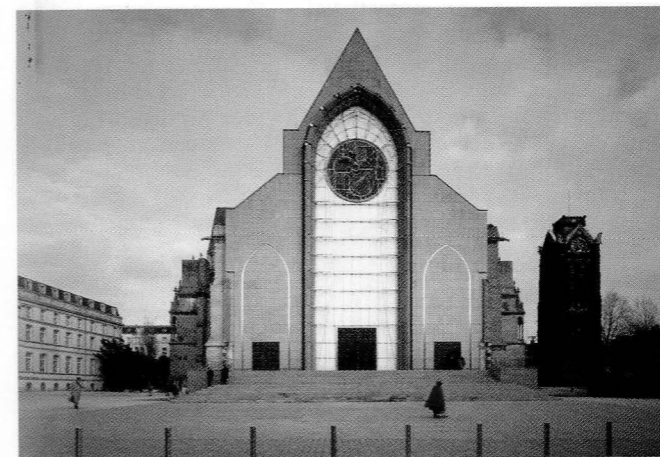
La Cattedrale di Lille in Francia. Articolo a pag. 1118 di Niccolò Baldassini, Mathias Kutterer. (In copertina e sopra foto di Jean Monthier).
